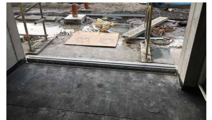
**Eindichten mit Los-Festflansch, Zugspitze**
