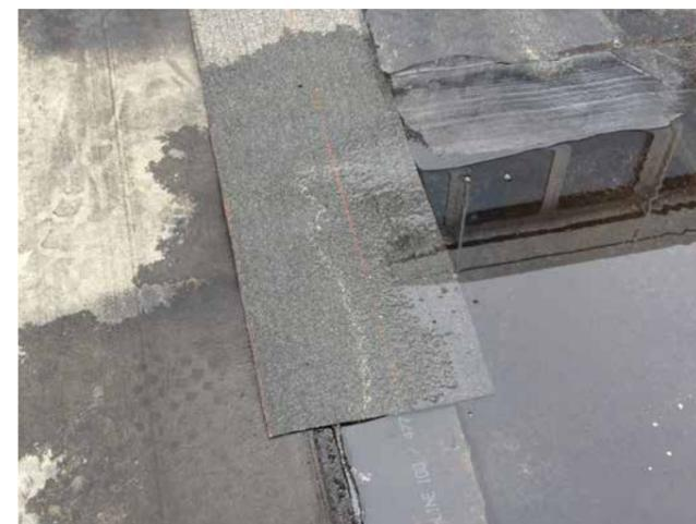
Bituminöse Eindichtung **FL 100 mit mechanischem Schutz**
