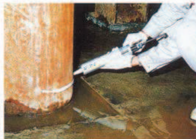
Til gulve med rørgennemføring
