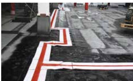
Vorkonfektionierte Bänder mit sämtlichen Formteilen für eine benutzerfreundliche Montage
